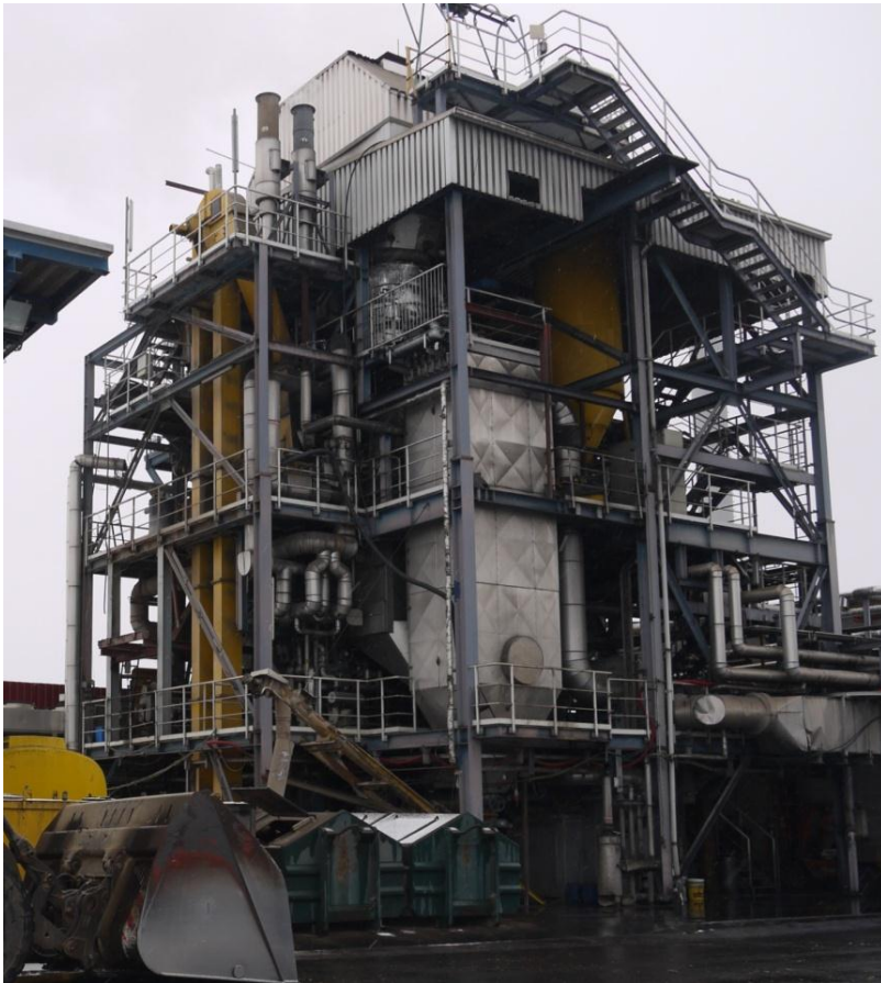
Foto : Hydrogenion AG : „Güssing“
